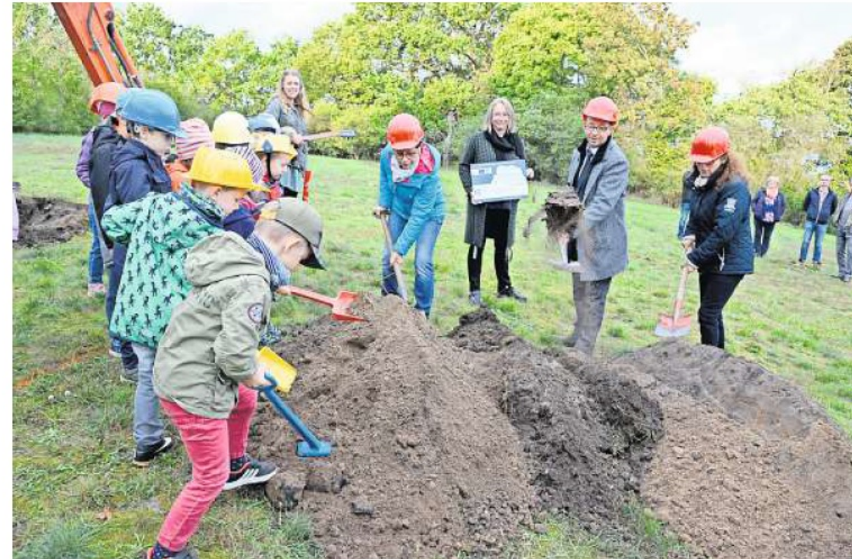
Groß und Klein beim offiziellen Spatenstich am Montagmorgen für den Kitanbau in Hennickendorf.
