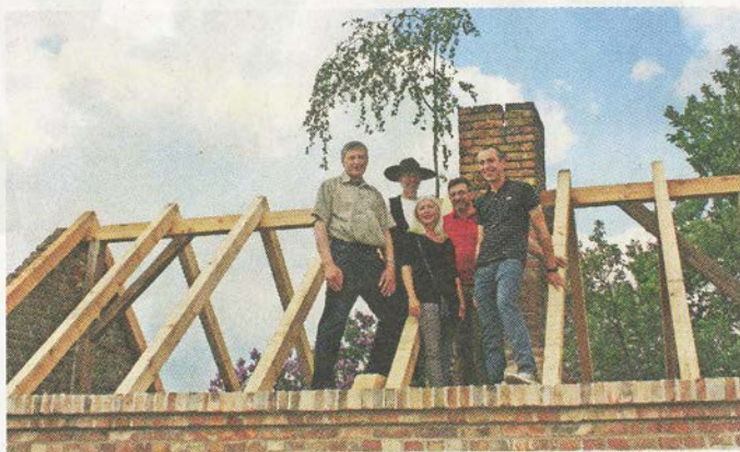
Richtfest für den Backofen-Dachstuhl.
