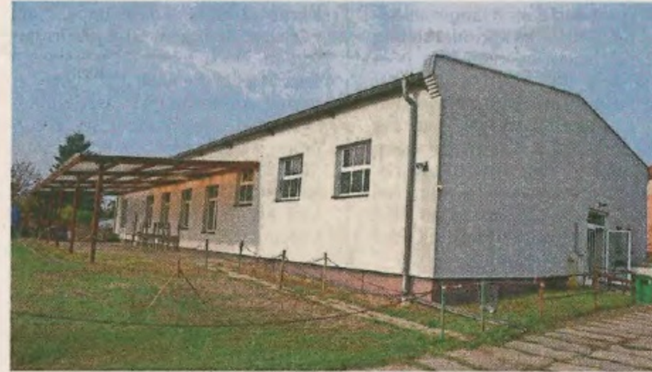
Die Turnhalle in der Sportfeldstraße in Trebbin.
