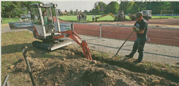
Im vergangenen Sommer begann die Sanierung der Jüterboger Tartanbahn. Nach der Winterpause starten am Montag die letzten Arbeiten.
